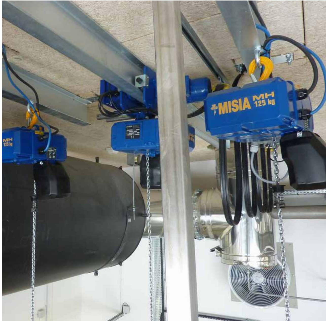
Impianto di verniciatura - Painting plant
