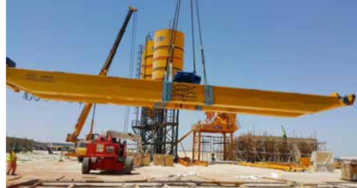
Costruzione di dighe - Construction of dikes
