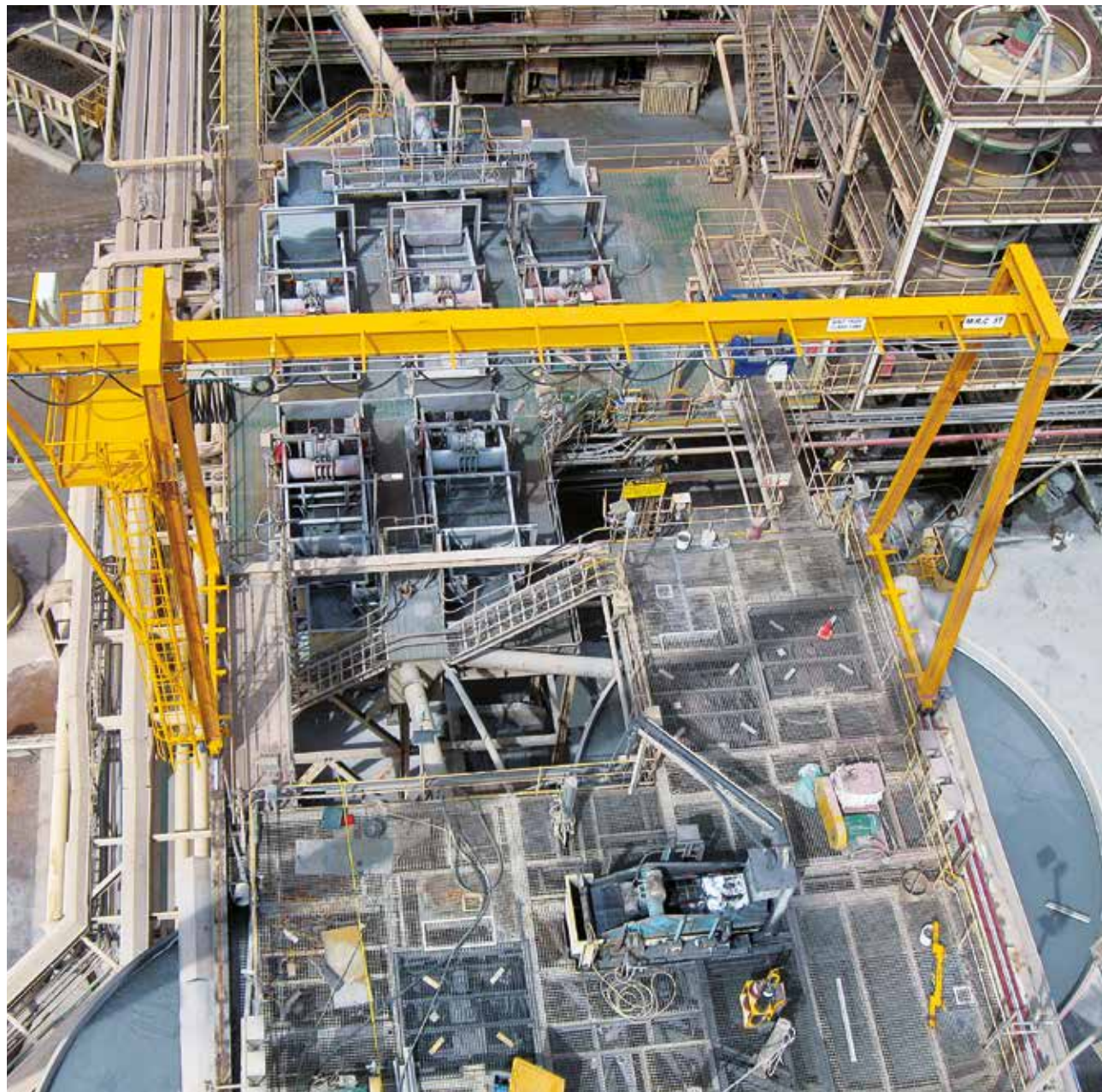
Preparazione materiale per fonderia - Preparation of foundry materials
