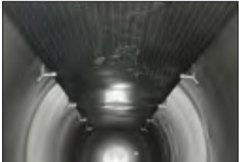
Sistema cascada de agua Water shower system
