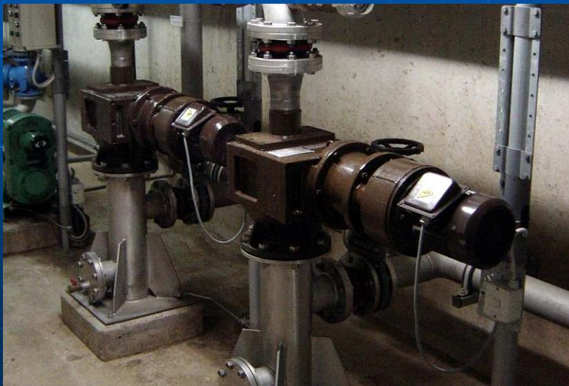
Zerkleinerung von Feststoffen / Faserstoffen im Klärschlamm vor der anaeroben Faulung
