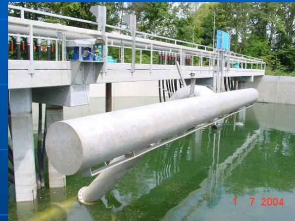
→ **Oberflächenbelüfter** nach dem Turbinenprinzip (BSK®)
