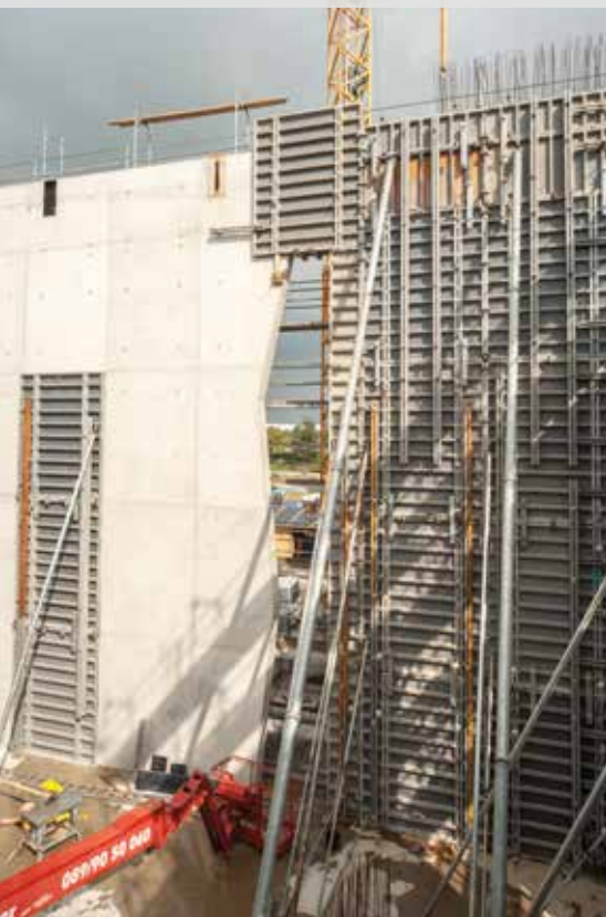
Gut sichtbar ist das durchgängige Schaltafel-Raster mit stehend und liegend eingesetzten Schaltafeln der Wandschalung.
