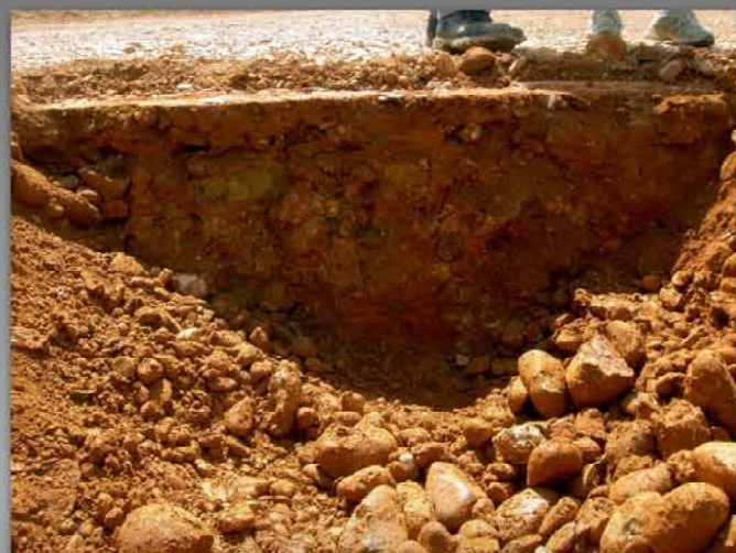
Chantier avec forte présence de silex
