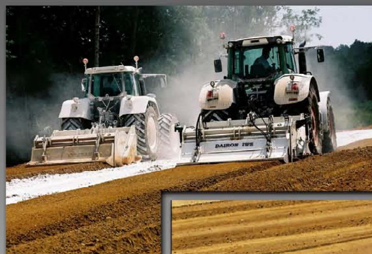
MSX 250 sur chantiers
