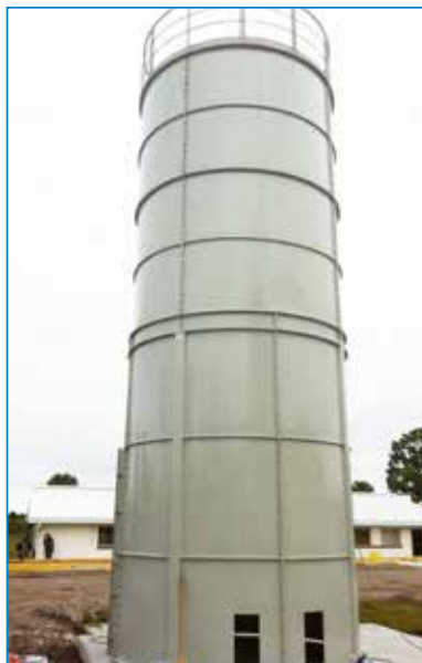
SILO CON GONNA AUTOPORTANTE
