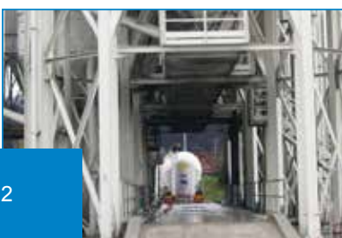
STRUTTURA A PORTALE PER PASSAGGIO CAMION GANTRY STRUCTURE FOR VEHICLES TRANSITING
