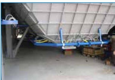
DETTAGLIO FLUIDIFICAZIONE A CANALINE
