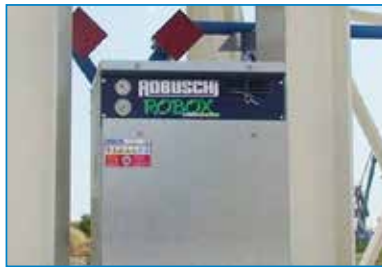
DETTAGLIO SOFFIANTE DETAIL OF AIR BLOWER
