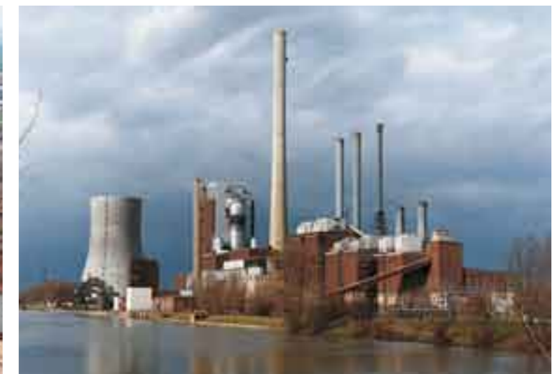
Coal-fired power plant with FGD and binderless gypsum briquetting units Kohlekraftwerk mit REA und bindemittelloser Gipsbrikettierung
