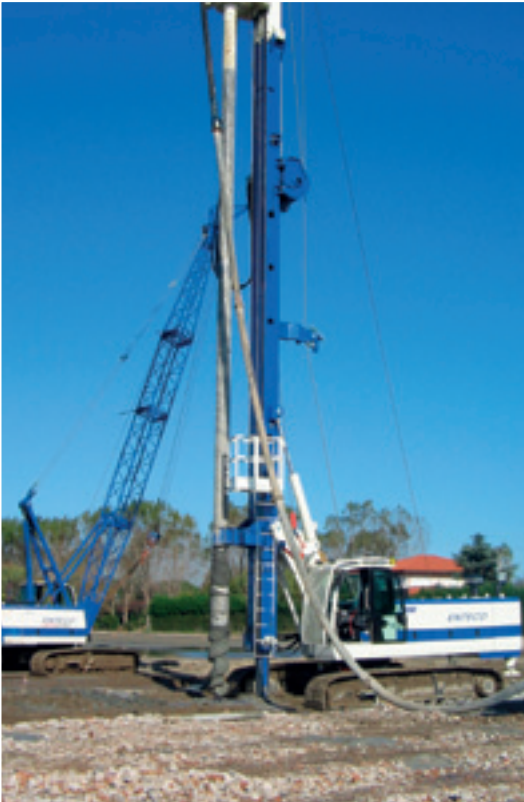
Ca' Dolina di Chioggia (ITALIA) Villaggio turistico E6050 – SP240 rig model Pali Soil Displacement ø 400 mm. Ca' Dolina di Chioggia (Italy) Holiday resort E6050 – SP240 rig model Soil displacement piles. Tool dia. 400 mm.
