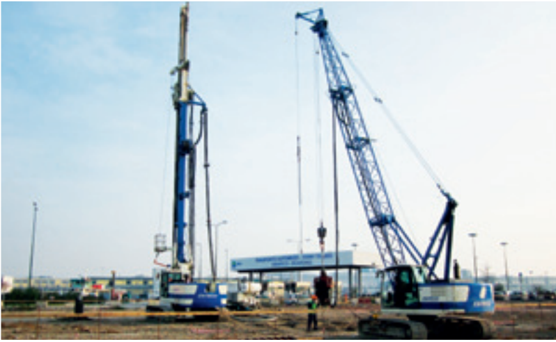
Ca' Dolina di Chioggia (ITALIA) Villaggio turistico E6050 – SP240 rig model Pali Soil Displacement ø 400 mm. Ca' Dolina di Chioggia (Italy) Holiday resort E6050 – SP240 rig model Soil displacement piles. Tool dia. 400 mm.
