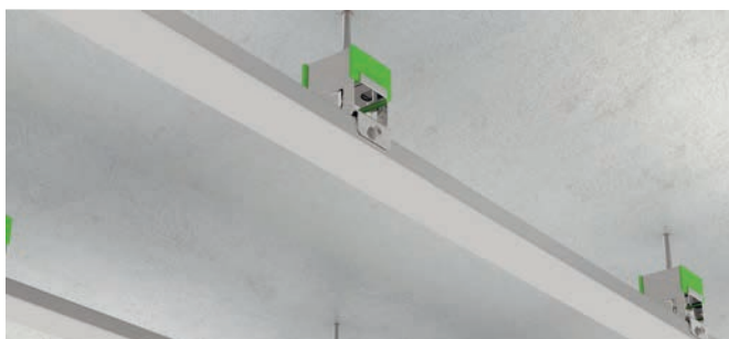
9.- Fixation des fourrures.
