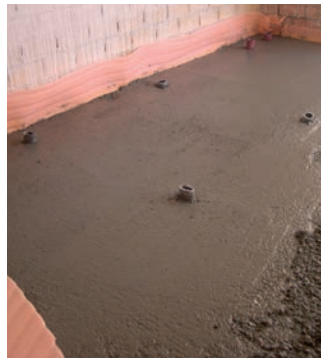
Installation du béton armé.
