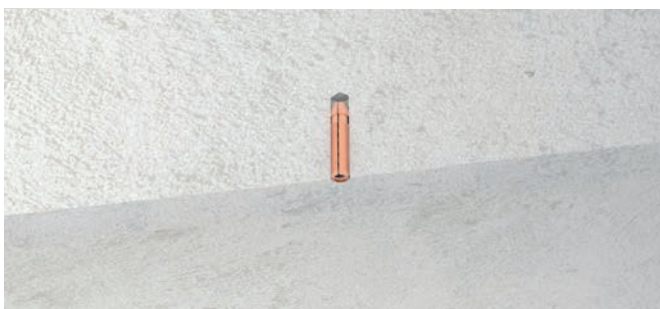
3.- Mise en place des suspentes acoustiques.
