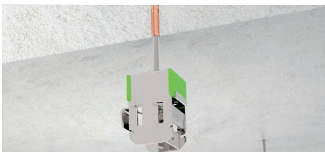
5.- Fixer les profils aux suspentes acoustiques.
