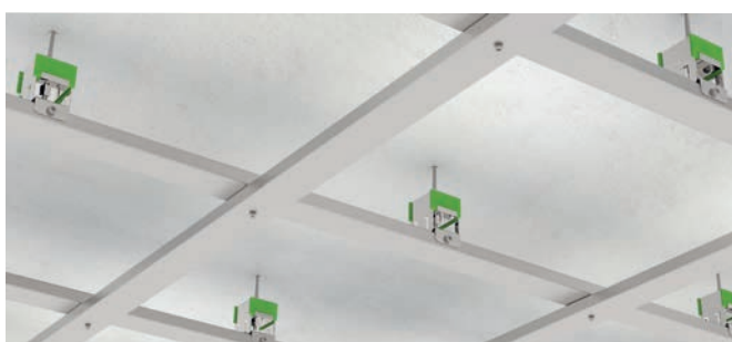
11.- Fixation des profiles.
