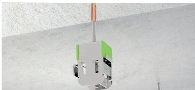
4.- Nivelar los soportes utilizando el laser para ello.
