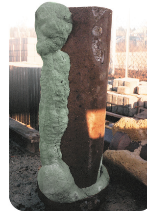
ausgegrabenes Rohr nach der Sanierung
