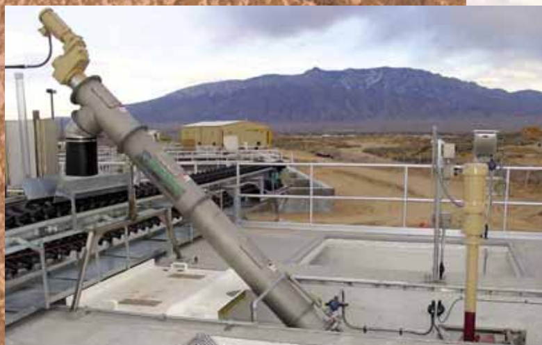
Auger Monster - modulární vtokové objekty ČOV
