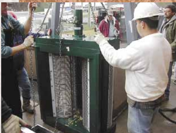
Montáž zařízení Channel Monster
