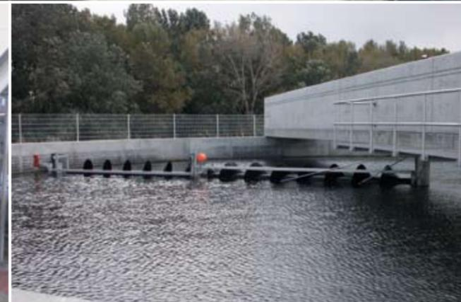
Nachklärbecken mit mechanischem Schwimmschlammabzug.
