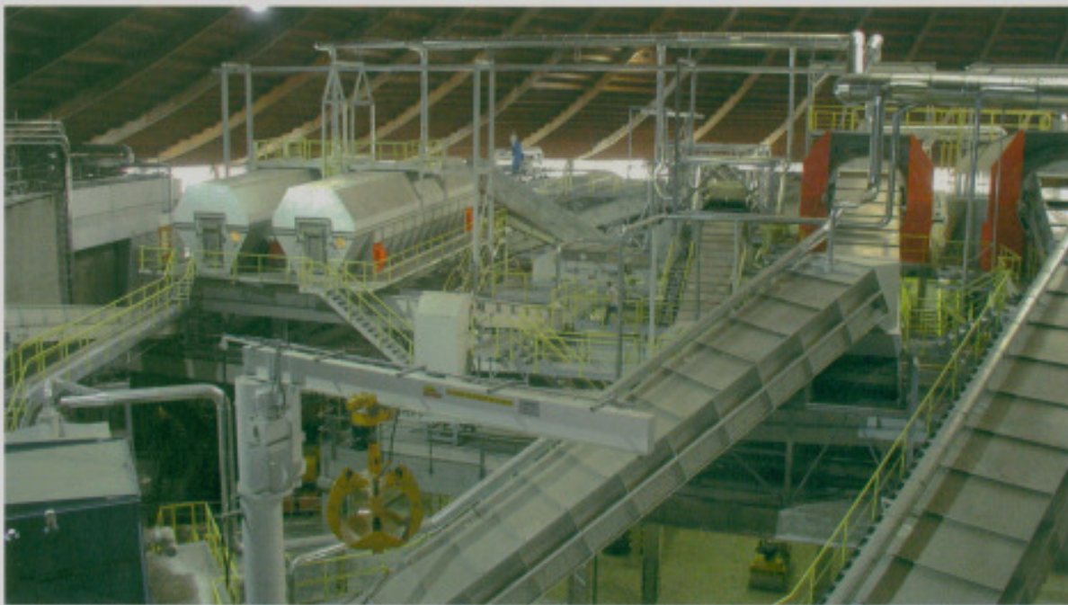
M-U-T Aufbereitungs- und Splittinganlage für Haushalt und Gewerbemüll
