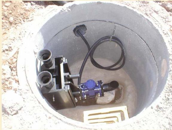
Führungsrohr mit Trichter
