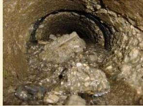
Ablagerungen (Sand, Geröll, Fett, Schlamm, Papier usw.) an den Wandungen und am Boden des Messgerätes verfälschen den Messwert, weil der Messquerschnitt nicht mehr stimmt.
