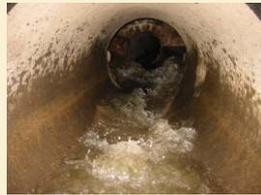
Zu kurze Rohre vor und nach Durchflussmessungen beruhigen das Abwasser nicht genügend. Wenn gleichzeitig große und kleine Abwassermengen erfasst werden sollen, wird entweder bei den kleinen oder bei den grossen Durchflüssen nicht richtig gemessen.
