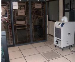
Faciles à transporter et à déplacer grâce à leurs roulettes robustes, ils se branchent sur une simple prise 16A/220V. Un réservoir escamotable, facile à vider, permet de récupérer les eaux de condensation.
