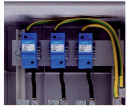
Le parafoudre Hs50-50 est implanté dans les établissements industriels, tels que les générateurs électriques et les distributions principales des grands bâtiments industriels avec grand risque de coups de foudre direct. Il est adapté pour les installations dont les parties de conduites électriques sont libres (avant le compteur d'électricité) suivant PNE 33 0000-5 respectivement la directive VDN, 2ème édition 2004 (TAB 2000).
