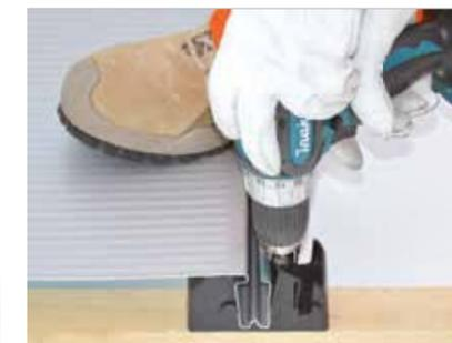
Fissare la staffa all'arcareccio utilizzando le apposite viti.
