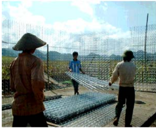
POSE DES PLANCHERS
