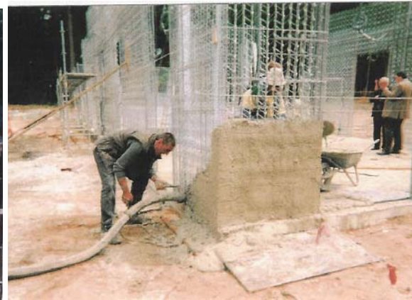
INJECTION DU BETON ALLEGE
