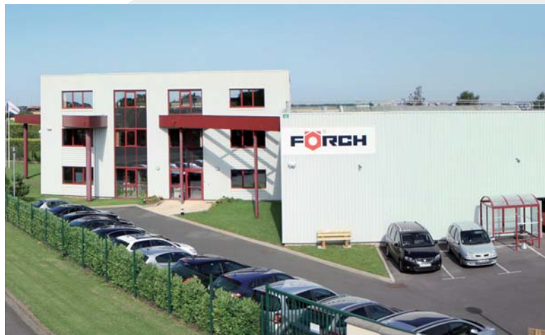
Le siège administratif de FÖRCH France, à Aubigny
