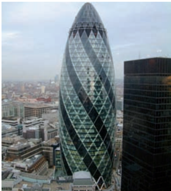
Bâtiment tertiaire, Londres (Royaume-Uni)
