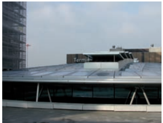
Aéroport de Zürich (Suisse)
