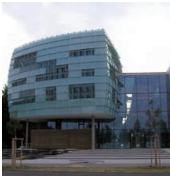
Bâtiment tertiaire, Allemagne
