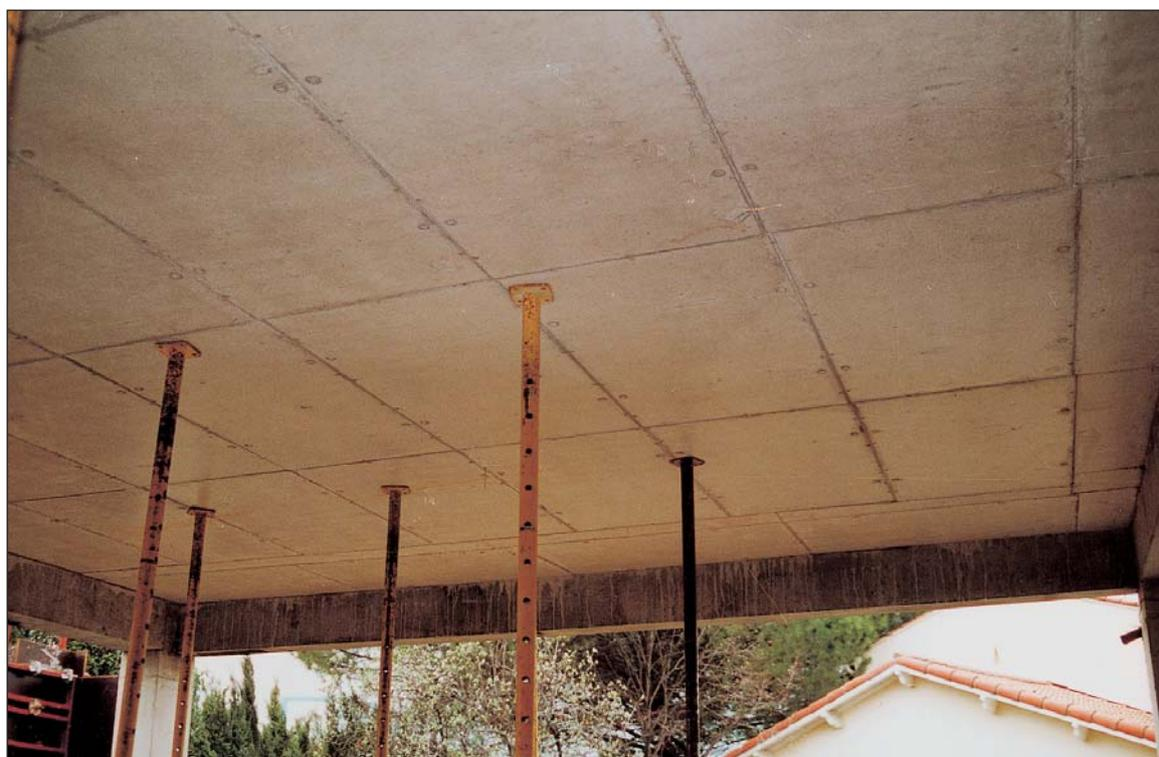
La qualité du combi finlandais et une parfaite étanchéité assurée par les serrures, participent à l'aspect soigné de la sous face de dalle.
