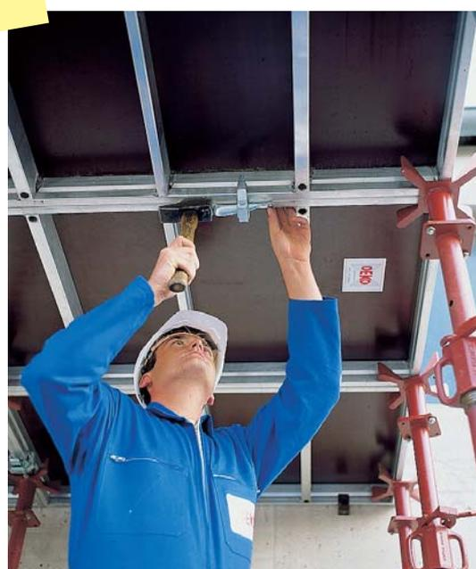
4 Verrouillage de la serrure au joint des deux panneaux.
