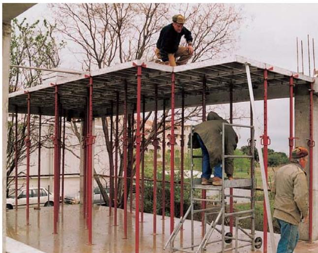
Pour les hauteurs d'étage supérieures à 3 m, la manutention des panneaux est facilitée par l'utilisation de l'escabeau DUALU.
