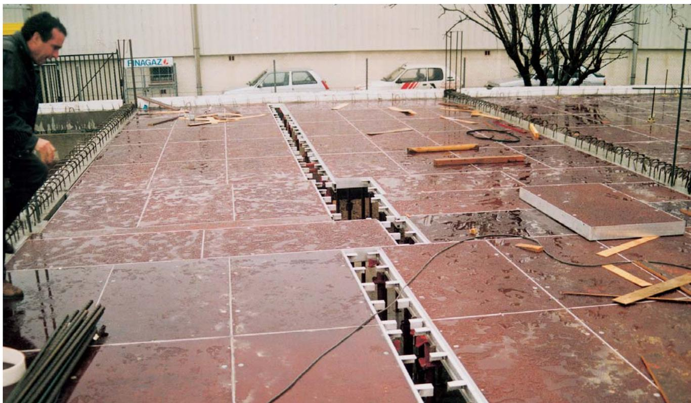
Les **profilés de correction** permettent d'adapter, sans aucune contrainte, le coffrage DUALU aux dimensions longitudinales ou transversales de l'ouvrage. On peut ainsi utiliser **un seul format** de panneau DUALU. Autres accessoires disponibles : **tôle de correction 132 x 35, serrure réglable.**
