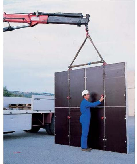
Mise en place des anneaux de levage. L'ensemble est maintenu vertical à l'aide du crochet grue (voir documentation banches alu).
