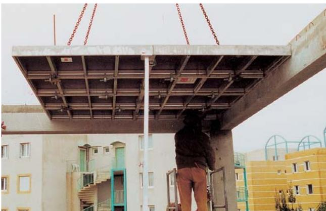
Mise en place ; calage provisoire à l'aide de la canne réglable, pose de 4 étais minimum avec trépieds avant décrochage des élingues.
