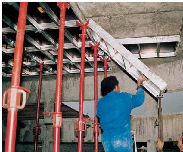
Le tiroir de décoffrage permet par un simple coup de marteau de décoller les panneaux de 15 mm. La canne accompagne le basculement de l'élément DUALU.
