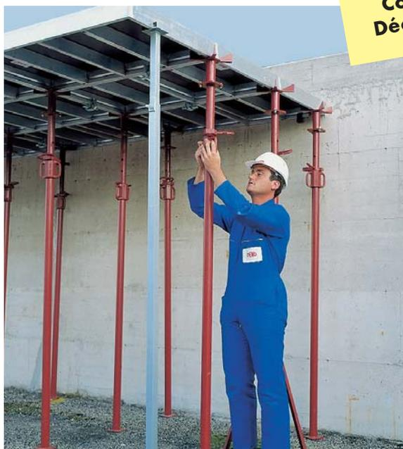
3 Mise en place de l'étai muni de la tête de dalle, maintient de la canne de coffrage en position d'attente.
