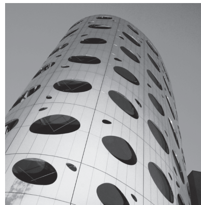
Une architecture futuriste avec revêtement en ALUCOBOND® : l'Hôtel Lindner Seepark à Klagenfurt, Autriche.
