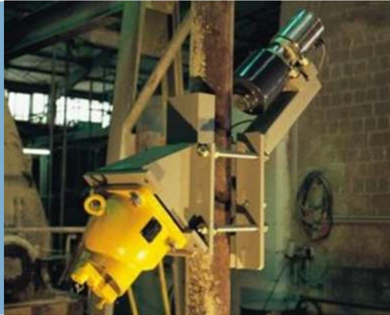
Le montage se fait soit de l'extérieur sur la tuyauterie existante soit - tout spécialement sur des tuyauteries de petit diamètre - par insertion d'une section de mesure sur la tuyauterie.
