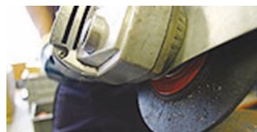
➔ NETTOYAGE DES JOINTS DE SOUDURE
