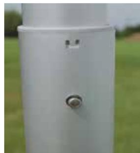
Cliquet de verrouillage des éléments télescopiques
