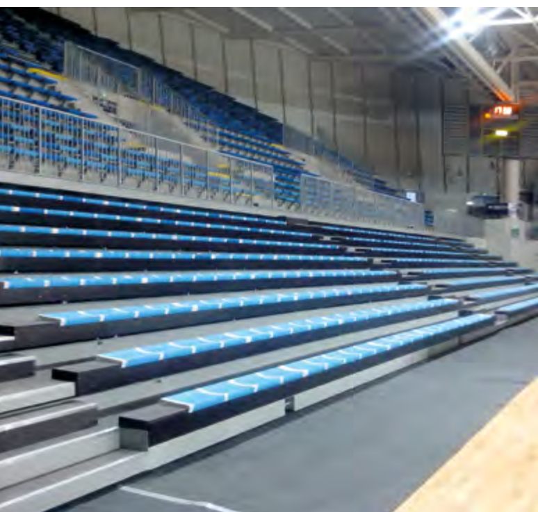
Tribune télescopique de 5 000 places assises, 6 modules de tribunes télescopiques et 3 tribunes fixes. La Pubeco Pévèle Arena à Orchies.
