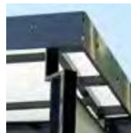
Support de toiture en acier zingué
