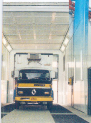
▲ RVI - Cabine de peinture à ventilation verticale
