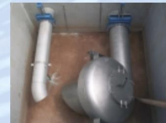
Régulateur vortex conique FluidCon (implantation sèche)
