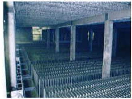
Le basculement en position verticale favorise aussi le glissement des boues encore retenues vers le fond de l'ouvrage. L'écartement des lames est alors maximal, ce qui facilite les opérations de nettoyage des lames.
