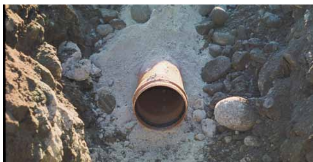
Fig. 17 - Sistemazione in terrapieno (posizione negativa).
