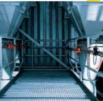
Des détecteurs inductifs détectent de manière fiable la position de trappes dans un silo.
