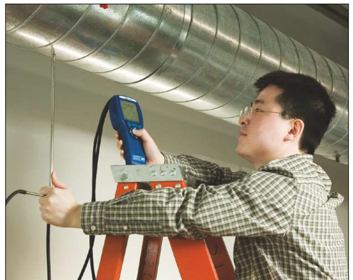
Strömungsmessung mit Prandtl-Staurohren
