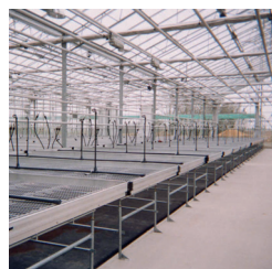
Portique implanté sur béton
