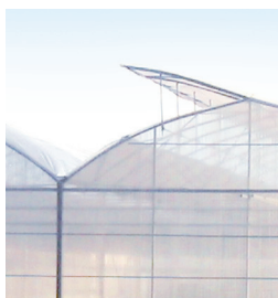
Ouvrant 3.20 sur faîtage d'Espace 9.60
