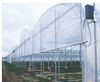
Rideau relevable par double enroulement
