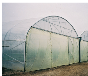
Pignon porte sur tunnel
