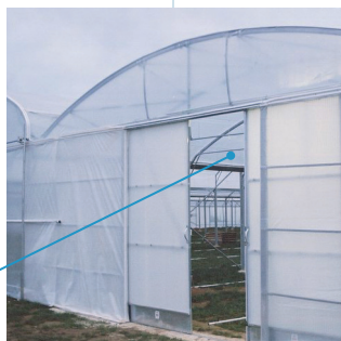
Porte coulissante acier sur pignon film sur MCB et SPID
