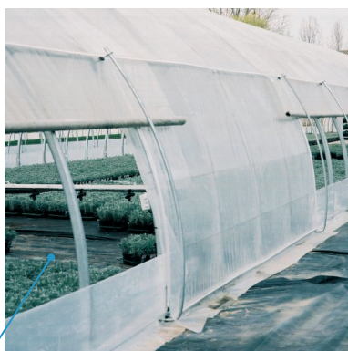
Aération latérale manuelle à manivelle
