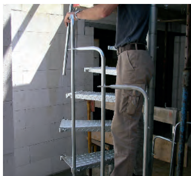
Geländerstäbe einfädeln und in Stufe stecken
