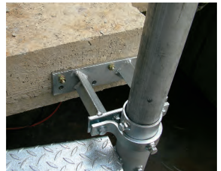
Spindelrohr mit Distanzhalter an der Deckenkante
