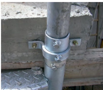
Rohrschellenbefestigung des Spindelrohrs ohne Distanzhalter
