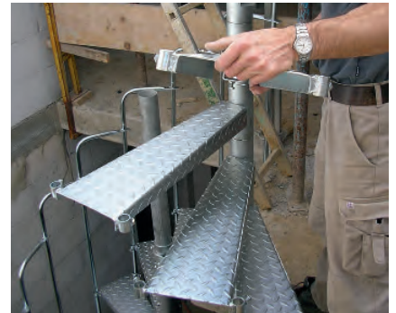
Stufen werden auf die Stufenhalter aufgesteckt
