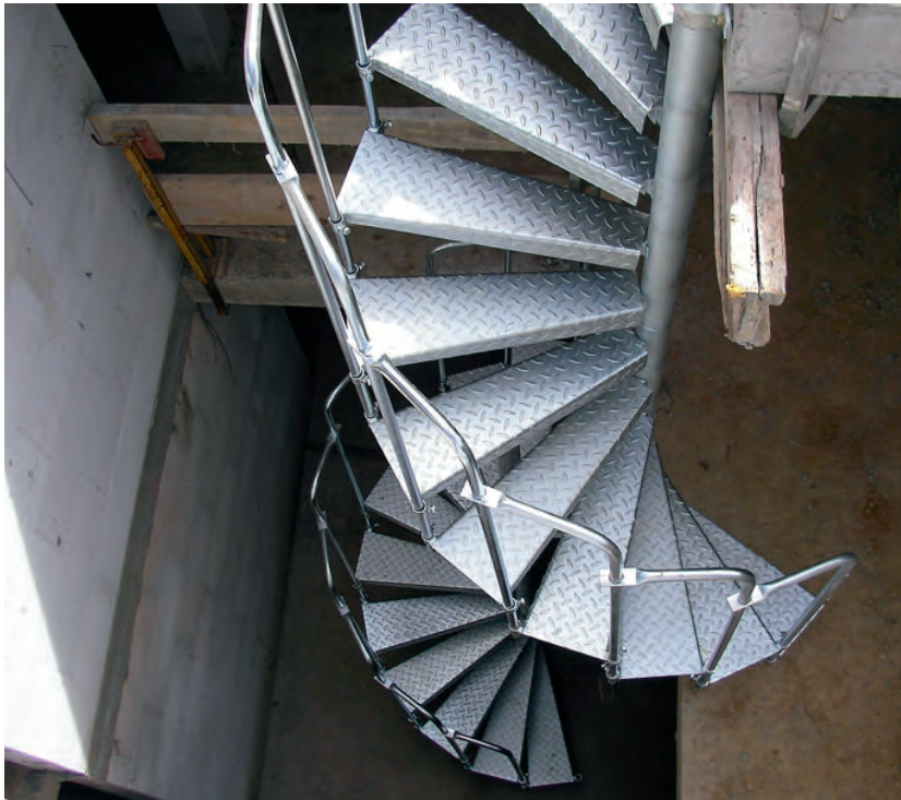
2 Geschoß Bautreppen fertig eingebaut von oben
