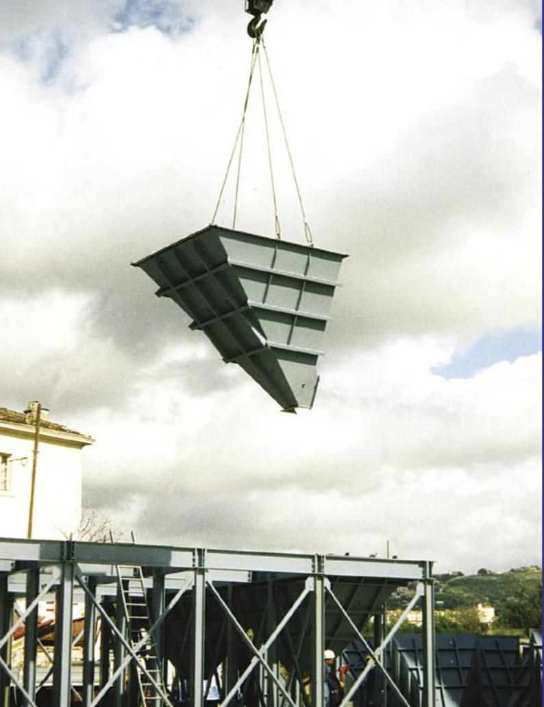
Il trasporto degli elementi che compongono il Terminal SR 1050 non necessita dell'utilizzo di mezzi speciali per trasporto eccezionale ma può essere effettuato con mezzi normali.
