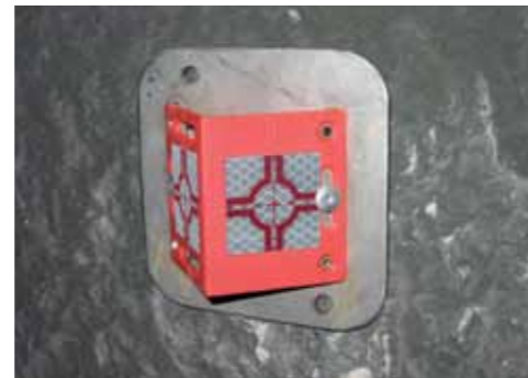
Tunnel Coen à Amsterdam
