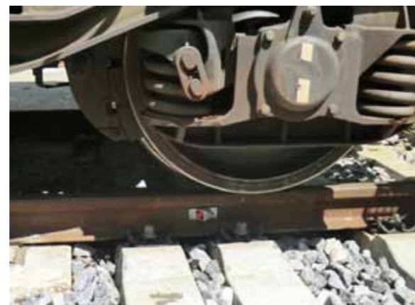
RSMP15, utilisé pour des mesures par une station totale robotisée, sous charge.
