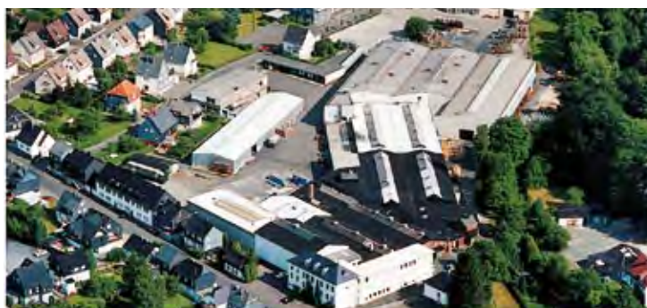
Hauptverwaltung / Produktion ROTHO, Neunkirchen
