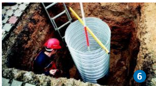
Anwendungsbeispiel: Strommastfundament, Foto 5 bis 10
