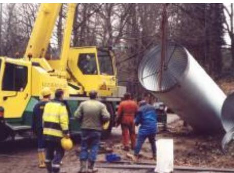
Verdrängungsrohr Ø1,8 m für Entlüftungsschacht im Tunnelbau
