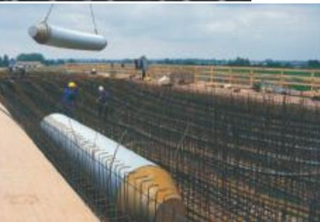
Einbau von VR-Rohren bei einer Brückenbaustelle in Wien
