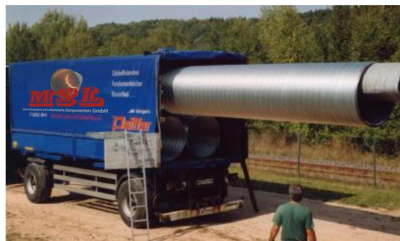
Verdrängungsrohre im Durchmesser von 0,95 bis 1,05 m für eine Brückenbaustelle in Afrika
