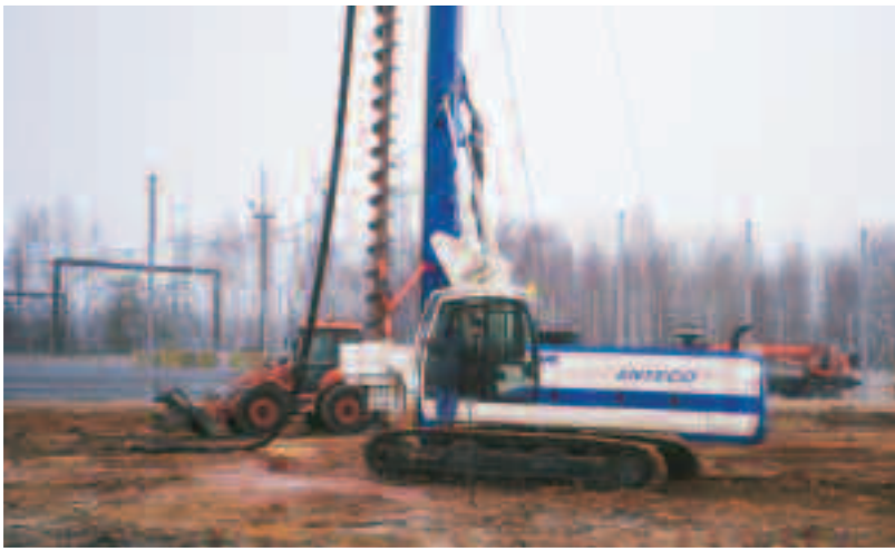
BOMBAY (INDIA). E6040-R150. Pali trivellati per fondazioni edificio residenziale.
