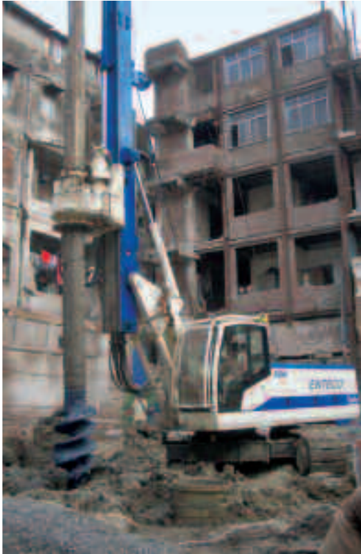
BOMBAY (INDIA). E6040-R150. Pali trivellati per fondazioni edificio residenziale.
