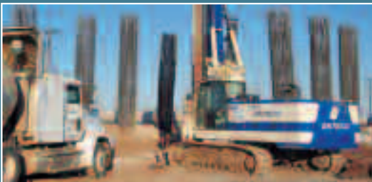
MESSICO E6040-R150. Pali trivellati per fondazioni ponte autostradale.
