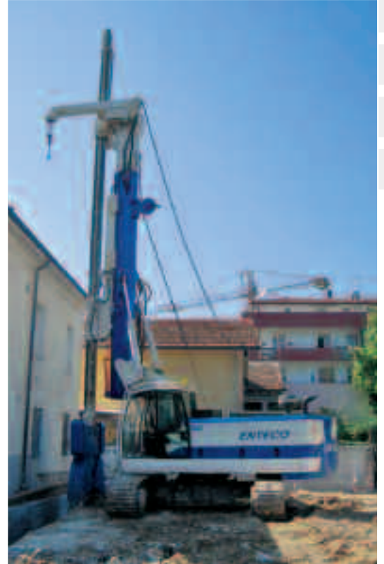
Cantiere RIMINI (ITALIA). E6040-HGM20. Diaframmi spessore 300 mm.
