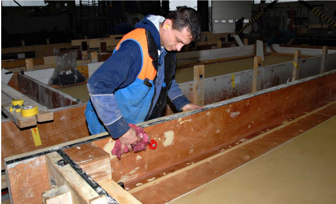
Le moule à béton est nettoyé pour une coulée suivante.
