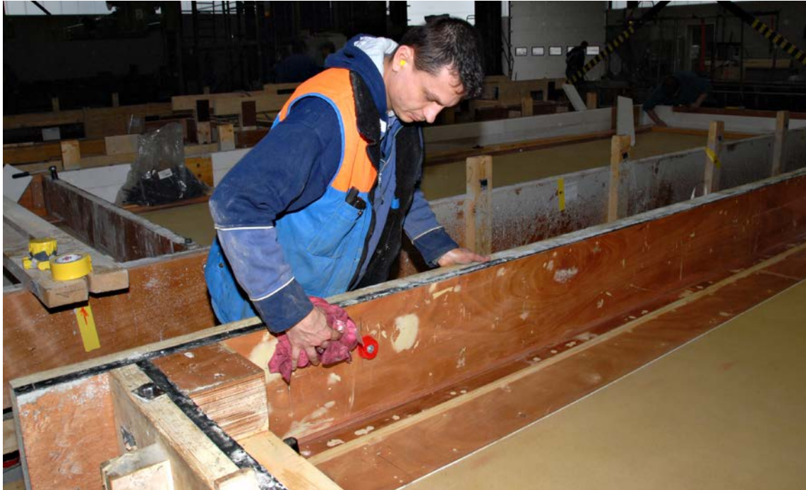
De betonmal wordt schoongemaakt voor een volgende betonstort.
