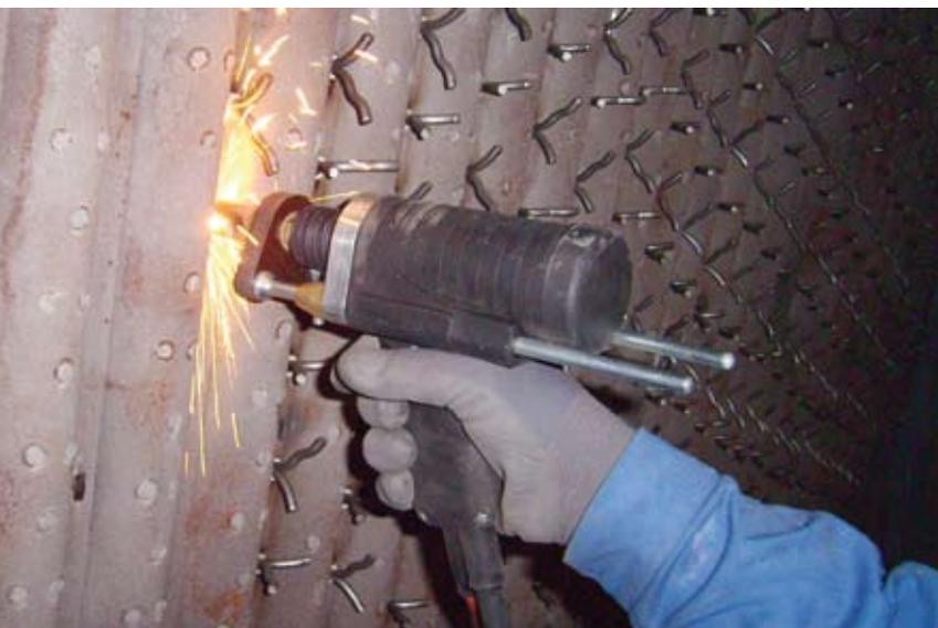
Ein funktionstüchtiges Feuerfestsystem ist in vielen Feuerungsanlagen ein wesentlicher Faktor für eine effiziente Verbrennung. Bindeglieder zwischen Kesselrohr und Feuerfestauskleidung sind metallische Verankerungselemente (Bolzen). Diese werden vorwiegend im Bolzenschweißverfahren angebracht.
