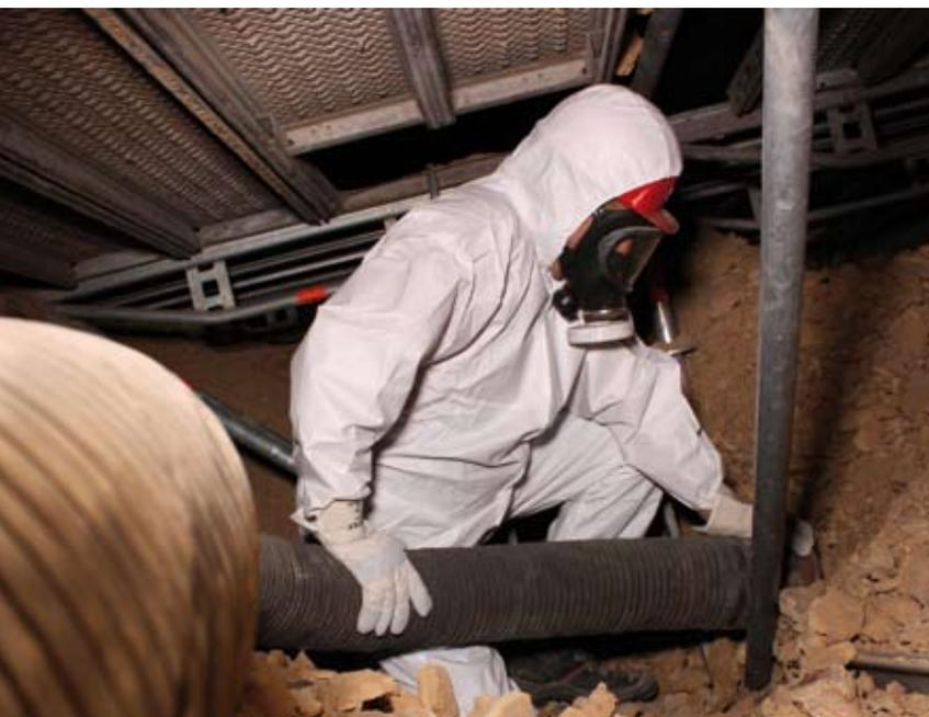
Unsere mobilen Saugwagen und Hochleistungs-Lufförderanlagen sind zugelassen nach GGVSE/TRbF und entwickeln eine Saugleistung bis zu 8.100 m<sup>3</sup>/h. Diese enorme Kraft sowie ein Aktionsradius von rund 300 m ohne Standortwechsel ermöglichen das Absaugen von staubigen, trockenen, pastösen oder flüssigen Medien.
