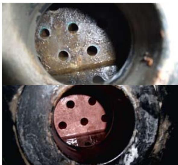
Ziel der chemischen Umlaufreinigung in fluidgeführten Systemen ist es, metallisch blanke Oberflächen in Wärmetauschern, Kondensatoren und Kühlern wiederherzustellen. Beläge wie Kalk, Eisen, Magnetit oder Biofilme werden aus Rohrleitungen entfernt. Verluste bei der Wärmeübertragung werden in den Geräten reduziert, Energiekosten gesenkt und der Lebenszyklus einer Anlage oder von Anlagenteilen wird erheblich verlängert.
