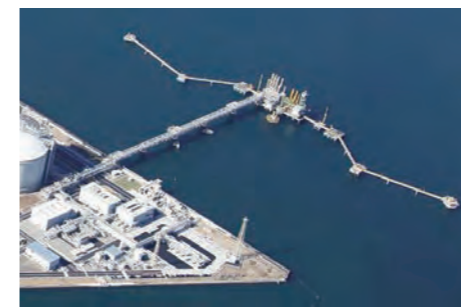
◇ Sakaide LNG Terminal (Kagawa Pref.)
