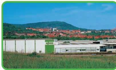
Sondershausen/Allemagne Site de production, centre logistique
