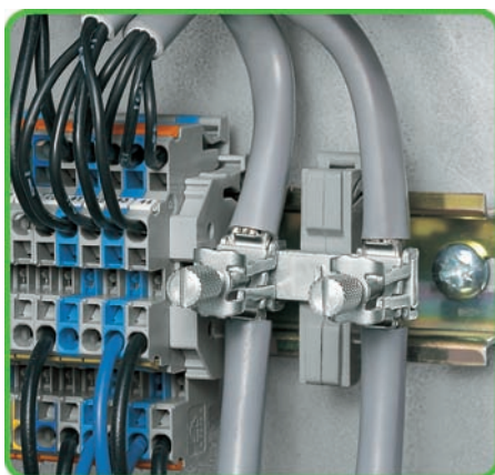
– support avec pied de dérivation, parallèlement au rail
