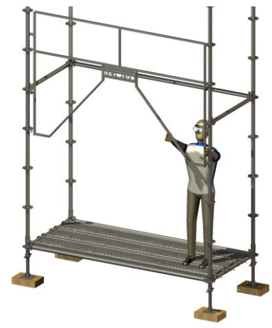
Fixation du garde-corps du côté du basculeur anti-soulèvement.
