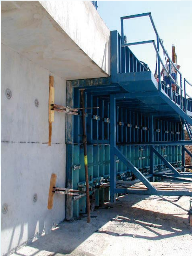
Adaptation spécifique avec coffrage métallique pour caniveau de bassin en station d'épuration.
