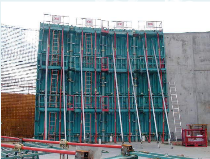
Réalisation de voiles d'une grande hauteur pour bassin de station d'épuration.
