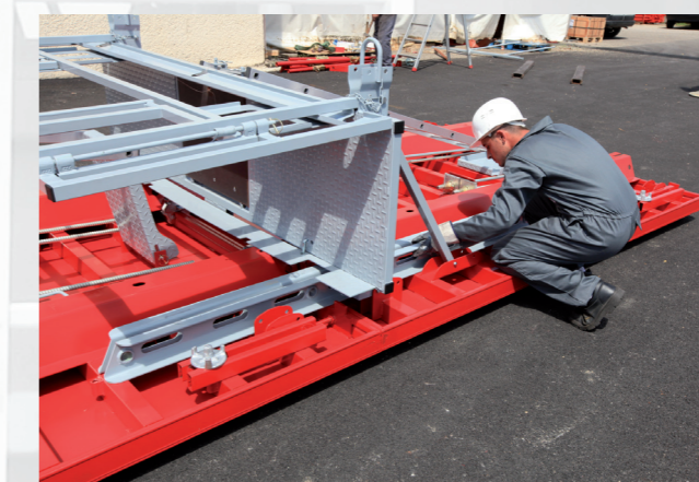
1 Mise en place de l'éclisse de manutention.
